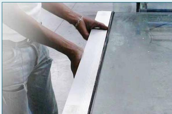
**3.4** Вставляйте горизонтальный профиль немного раскачивая его, затем киянкой не сильными ударами осадите профиль до плотной фиксации профиля на резине.
