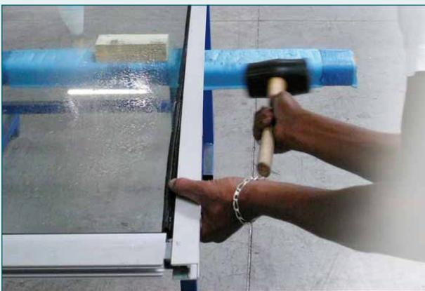
**4.4** Совместите торец вертикального профиля с торцом горизонтального профиля и резким движением вставьте профиль на уплотнительную резину. Лучше эту операцию проделывать вдвоем.
