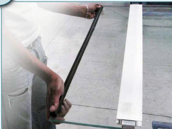
**3.1** Вставьте уплотнительную резину в паз горизонтального профиля и отрежьте по его размеру. Контролируйте ровность среза торцов. Для стекла толщиной 8 мм дайте припуск резинового уплотнителя по 2 мм на сторону. Если стекло толщиной 9 – 10 мм удалите уплотнительную полоску резины во внутреннем пазе резины.
