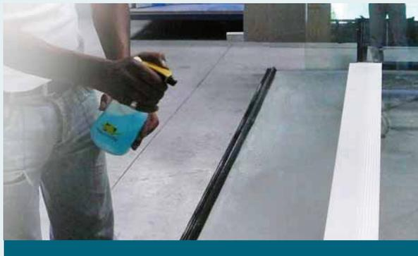
**3.3** С помощью распылителя нанесите мыльный раствор на уплотнительную резину сверху и снизу
