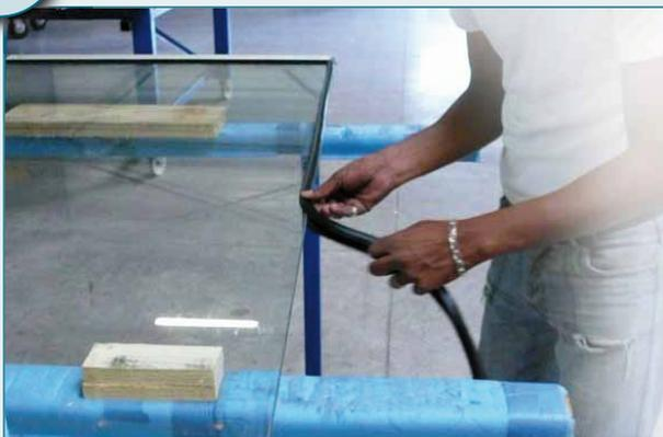
**4.1** Установите резиновый уплотнитель на стекле между установленными горизонтальными профилями так чтобы край уплотнителя внахлест ложился на уплотнитель в горизонтальном профиле. Удалите уплотнительную полоску во внутреннем пазе уплотнителя, если толщина стекла 9 или 10 мм.
